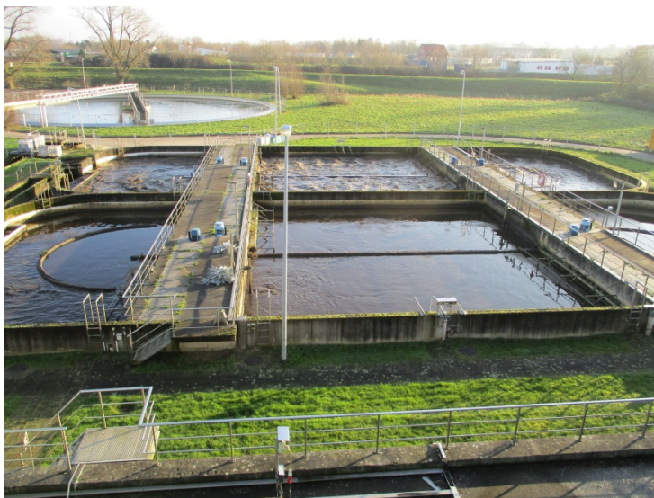
Foto: Abwasserentsorgung Stade
