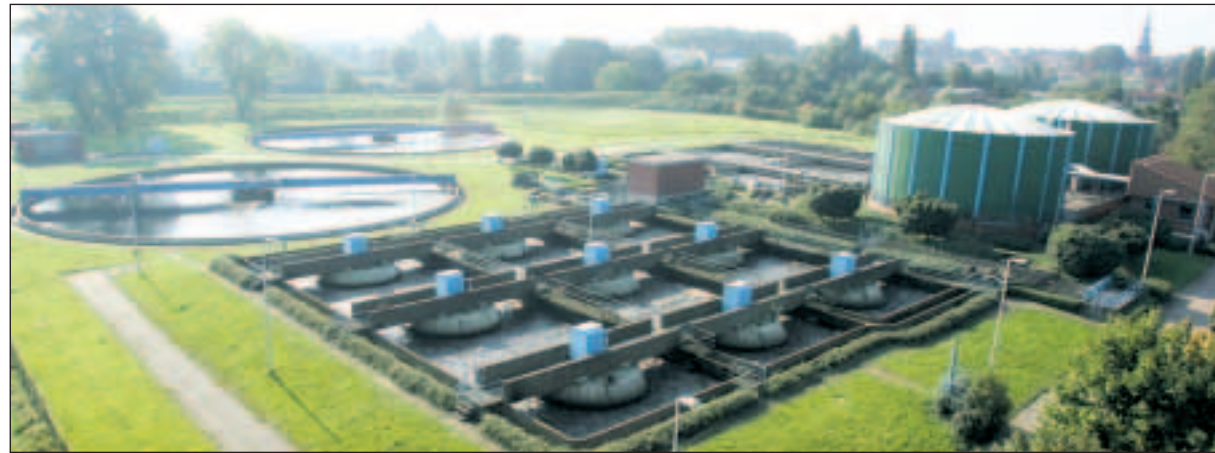
Millionen für die Sanierung erforderlich: das Stader Klärwerk.
