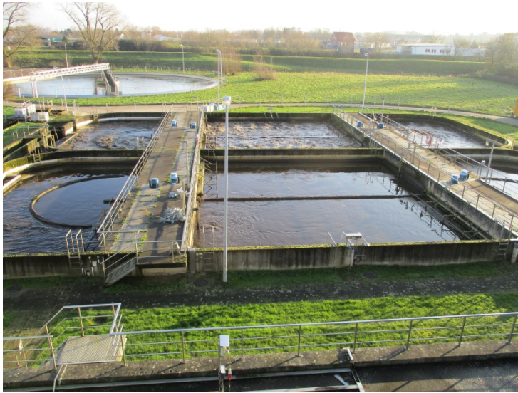
Foto: Abwasserentsorgung Stade
