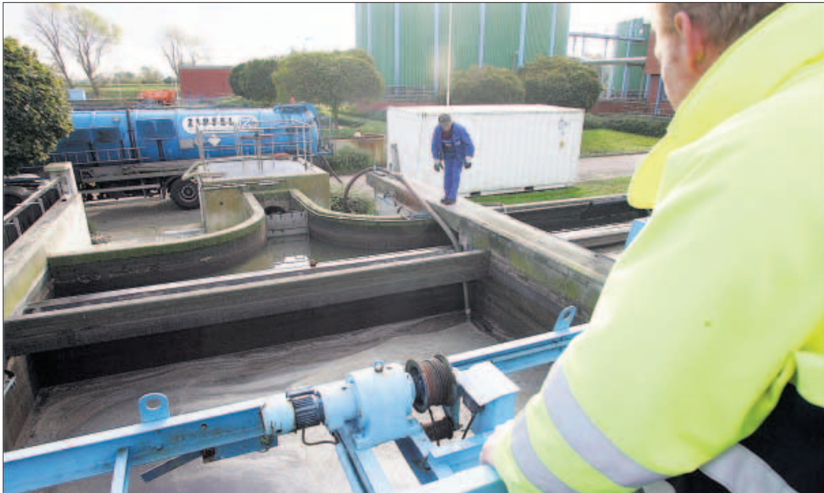
Abwassermeister Michael Schröder (rechts) blickt auf das „Havariebecken“ des Stader Klärwerks. Ein Spezialfahrzeug im Hintergrund saugt den Schadstoff-Film von der Oberfläche des Wassers ab. Fotos: Schmidt
