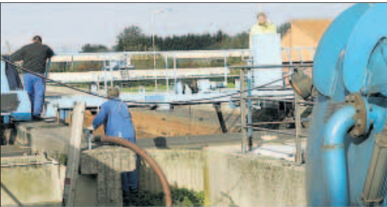
Reinigungsaktion im Stader Klärwerk.
